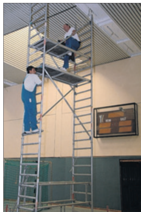
Arbeiten in luftiger Höhe: die Osthalle hat eine neue Beleuchtung erhalten. Foto: Birgit Kiefer
